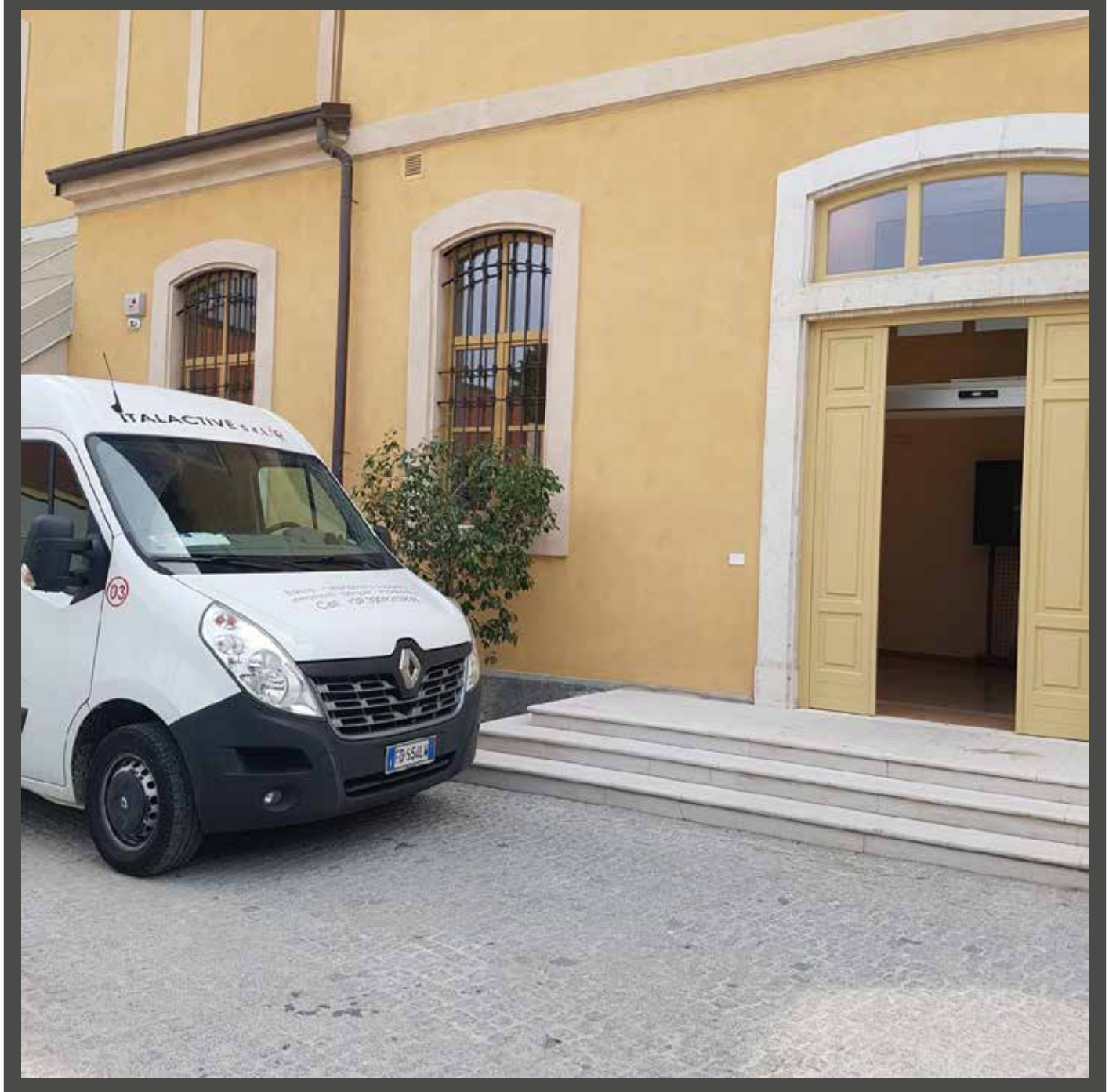
Ristrutturazione biblioteca di Palazzo Arcioni – Ghedi
